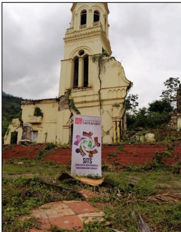
Foto 10. Ruinas del templo histórico del antiguo casco urbano de Gramalote.
